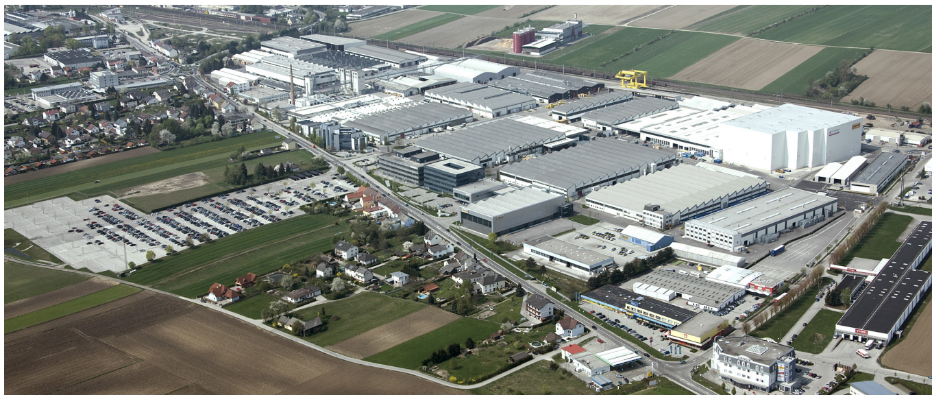
Κεντρικές εγκαταστάσεις του ομίλου Doka στο Amstetten, Αυστρία
