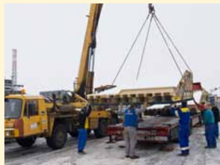
▲ Nakládka bednění hlavic
