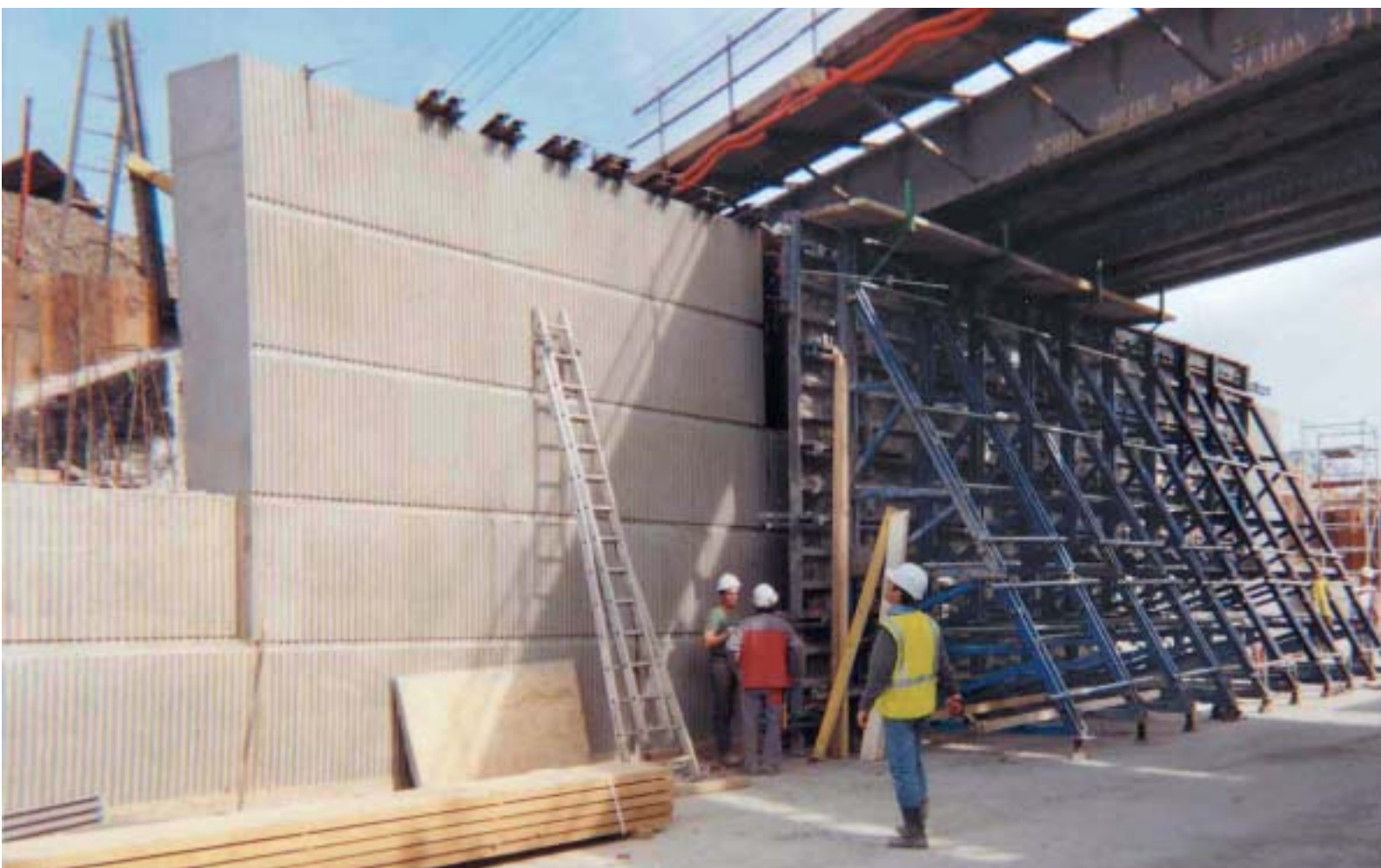
Chantier : Pont SNCF Mouchard à Bourg en Bresse Entreprise : Chantiers Modernes Agence : Doka Lyon
