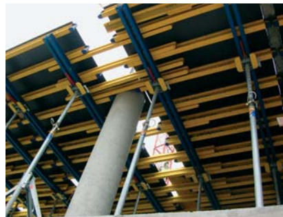
Kiegészítés: Dokamatic zsaluzatok kiegészítése H16 fióktartóval a leggyorsabb
