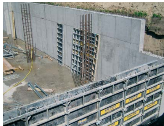
A Frami270 minden gond nélkül 4 m-ig magasítható
