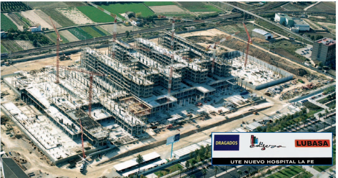
Vista aérea en fase de construcción del Nuevo Hospital de La Fe
