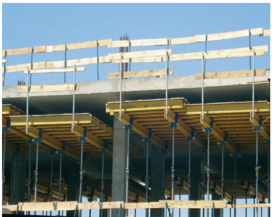
El desencofrado de mesas fue fácil y rápido. Ya están listas para su próximo uso.
