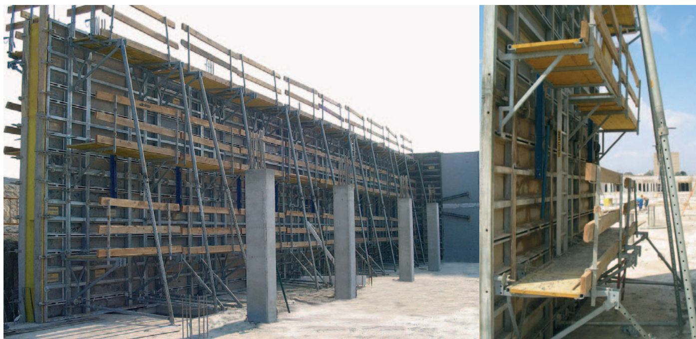
Encofrado Frameco con plataformas GF y apuntalamiento para muro perimetral. Las vías de trabajo quedan siempre libres para poder trabajar de manera segura pudiendo subir de un nivel a otro por las escaleras que están fijadas al encofrado.
