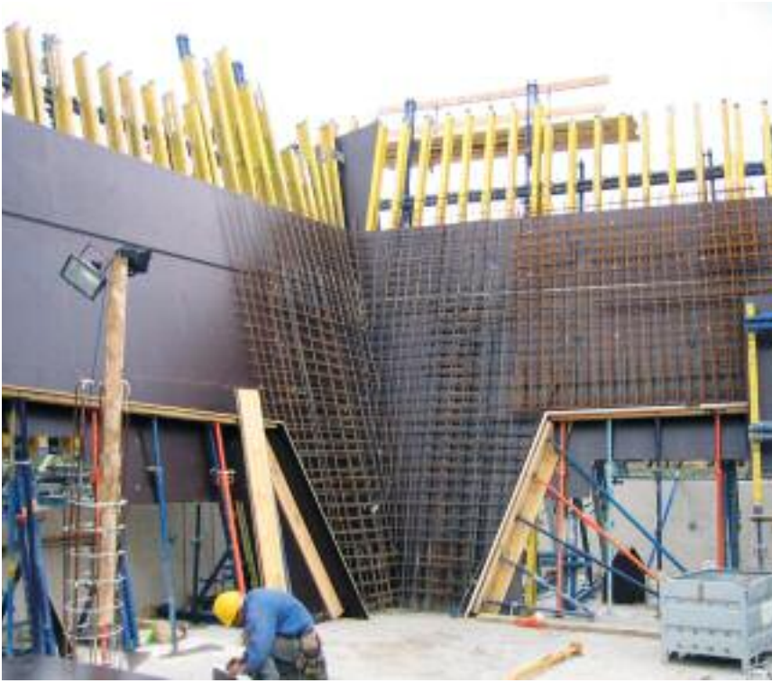
Encofrado de vigas Top 50 en esquinas inclinadas. ▲ Se puede elegir libremente el tipo de forro
