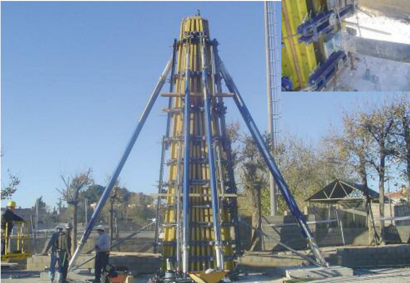
Pila encofrada con apuntalamiento Eurex 60 550 ▲
