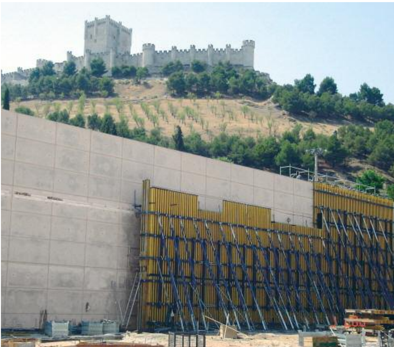
Encofrado Top 50 para muro perimetral con castillo de Peñafiel al fondo ▲
