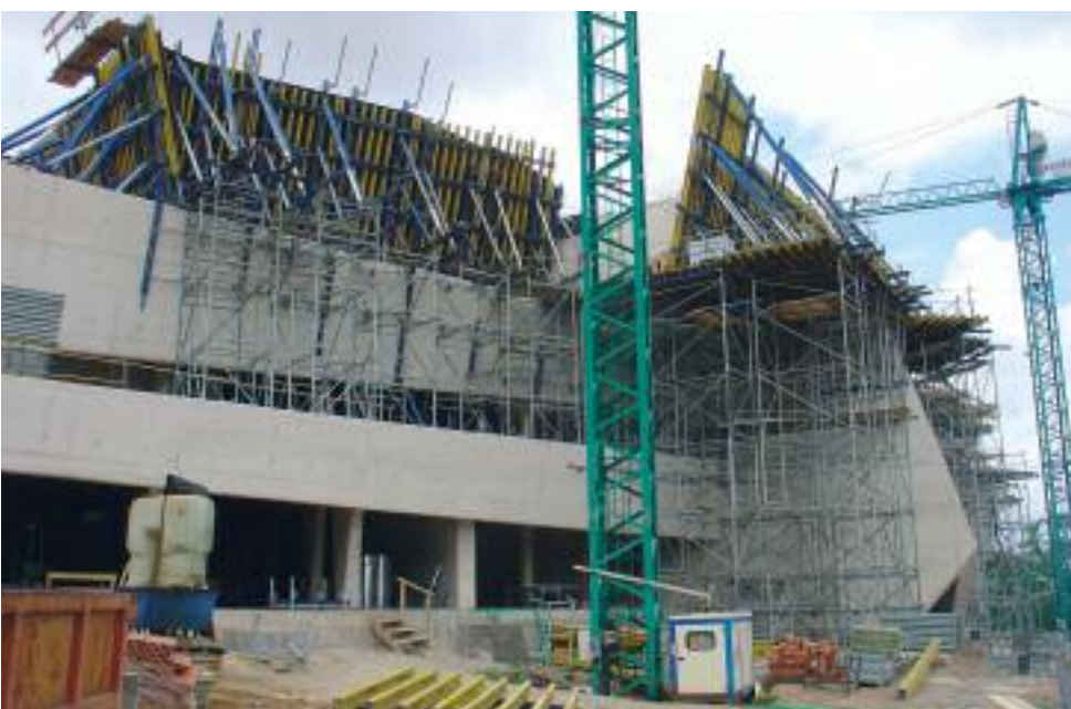
▶ Bodegas Pradolagar, La Rioja. Exigentes formas de construcción con el encofrado de vigas Doka Top 50 y cimbra d2
