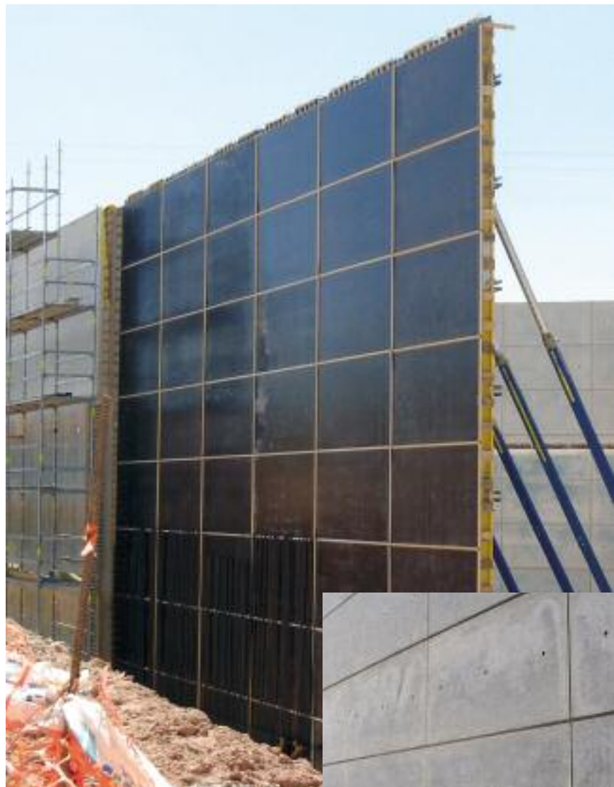
Detalles de berenjenos y corte de tablero ▲
