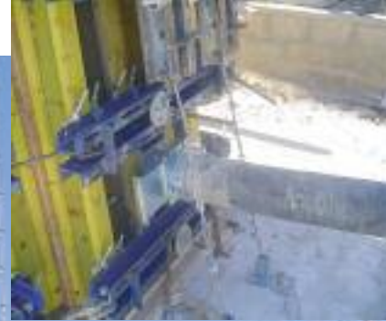
Detalle de la boquilla de llenado ▶ Doka GF SCC
