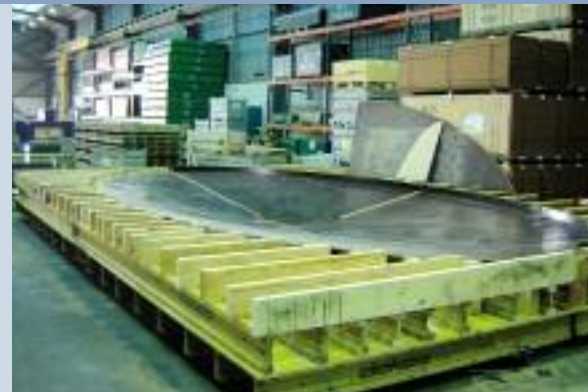
Los encofrados premontados desde los almacenes facilitan los proyectos de grandes exigencias ▲
