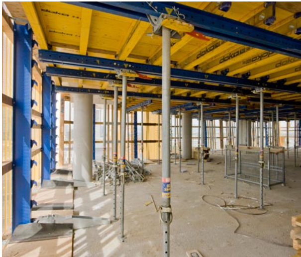
Situación del forjado encofrado donde se aprecia un ambiente de trabajo seguro y confortable sea cual sea la altura
