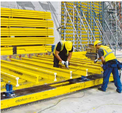
Schalungsvormontage auf der Baustelle
