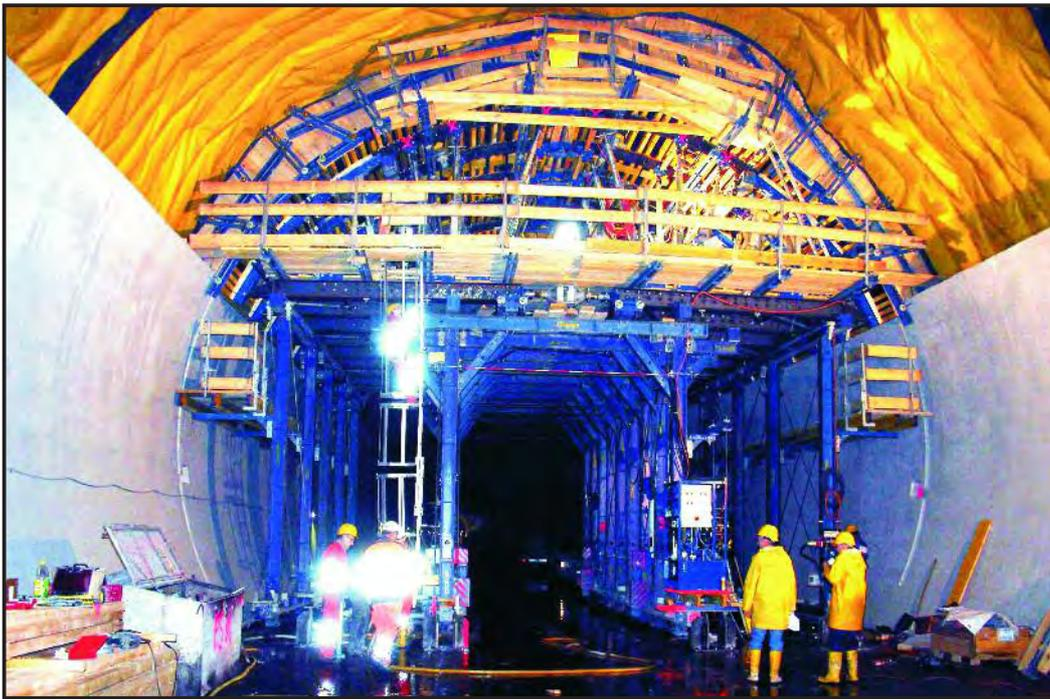
Al cabo de tan solo dos meses, esta sección de la caverna estuvo lista, entonces el carro de encofrado se modificó para la sección más ancha.
