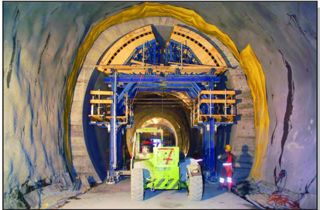
Para pasar al siguiente tramo del ventilador, se desarrolló una solución sencilla pero eficaz: En la parte central del encofrado de vigas Top 50 se pudo retirar un elemento del encofrado para juntar las dos mitades que quedaban del encofrado y poder pasar por la sección del túnel estándar (más estrecha que la del ventilador a chorro).
