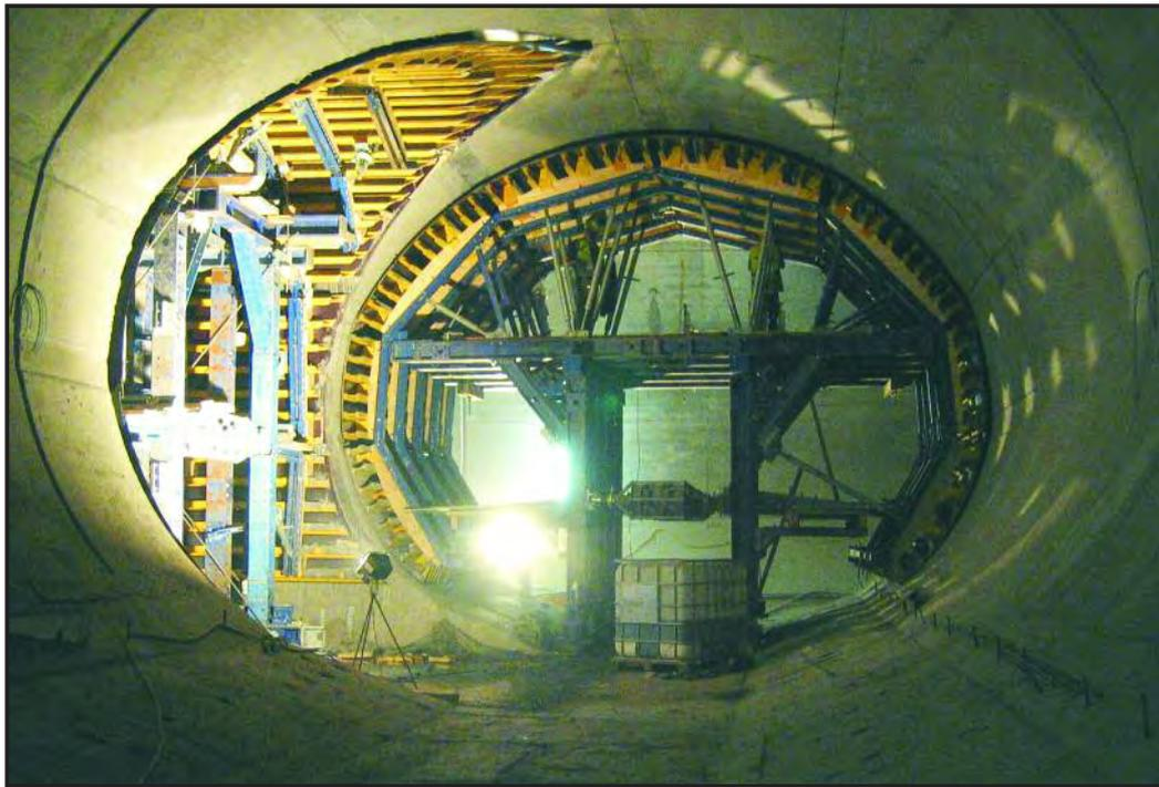
Un reto especial eran los trabajos de encofrado de las tres zonas de intersección. Los elementos de encofrado de vigas con una forma especial se premontaron para garantizar la máxima exactitud.
