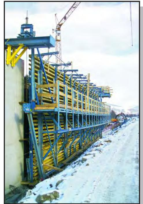
Los elementos del encofrado exterior estaban premontados en posición horizontal y se habían levantado de forma conjunta en una unidad. Estaban suspendidos en la parte delantera y trasera sobre vigas transversales y se podían mover en sentido horizontal por medio de crics de cremallera.
