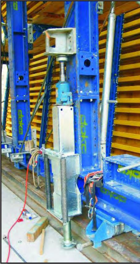
***Mecanismo de elevación SL-1***
