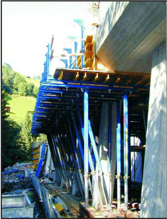
Los elementos del encofrado que sobresalían de los pilares estaban unidos al carro de encofrado. Durante el hormigonado se soportaron con puntales Eurex 60.
