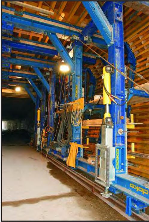
**Los cilindros hidráulicos hicieron posible elevar y descender rápidamente el carro de encofrado.**
