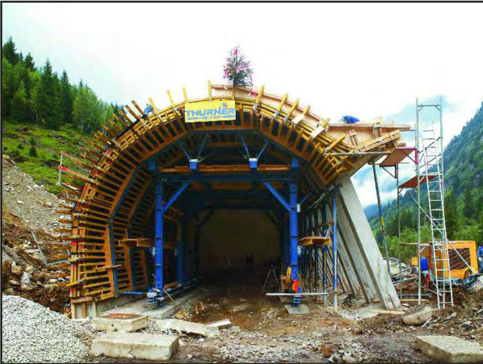
Para el desplazamiento, primero se desencofró la zona del voladizo por medio de una grúa horquilla.
