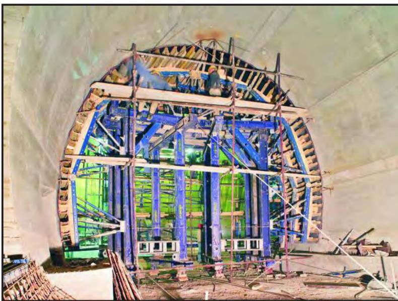
Un reto especial para los técnicos de encofrado de Doka fue el ensanchamiento en forma de trompeta de los dos grandes túneles transversales.
