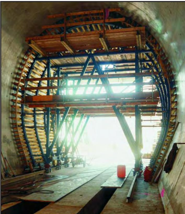
... incluso con la misma estructura sencilla de la sección del encofrado interior.
