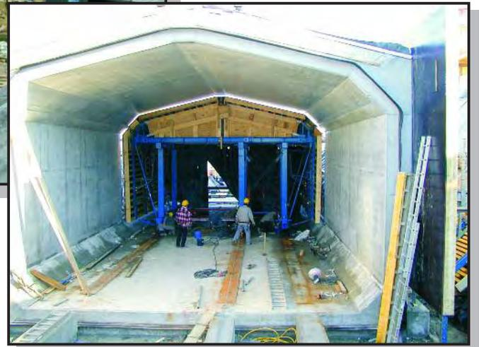
**Sección tipo del carro de encofrado:**
