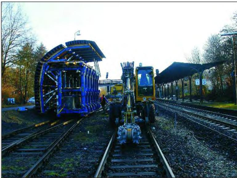
Para mantener el tráfico ferroviario (de lunes a viernes) el equipo de encofrado debió ser extraído del túnel en su totalidad después de completar cada puesta utilizando una excavadora.
