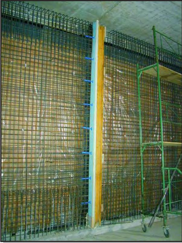
Se disponía de tapes de encofrado dobles por lo que se podían montar previamente en la sección siguiente. Esto permitía obtener tiempos de desplazamiento de ciclos de un día.
