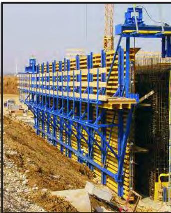
*Por los dos lados y al mismo tiempo se desplazaron hacia delante los elementos del encofrado exterior de 170 m<sup>2</sup> por la barra de desplazamiento. El mecanismo de desplazamiento instalado ofrecía la estabilidad necesaria para poder realizar el encofrado y el desencofrado con sólo 2 gatos en el extremo.*
