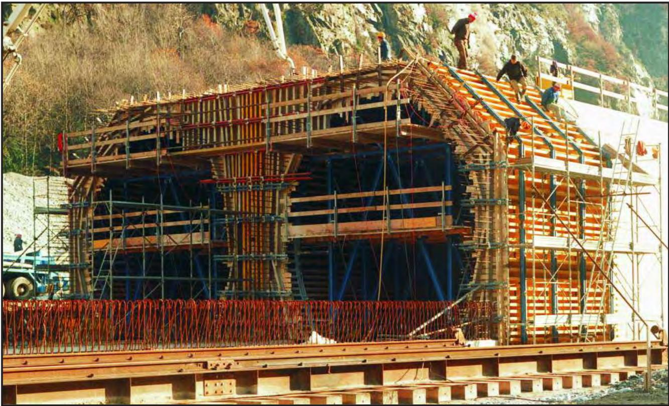
*Cuando a las 20 etapas el tubo doble se divide en dos, en el túnel de Bodio sólo ...*
