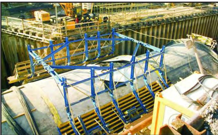
Vista del encofrado exterior, arco de tres articulaciones autoportante
