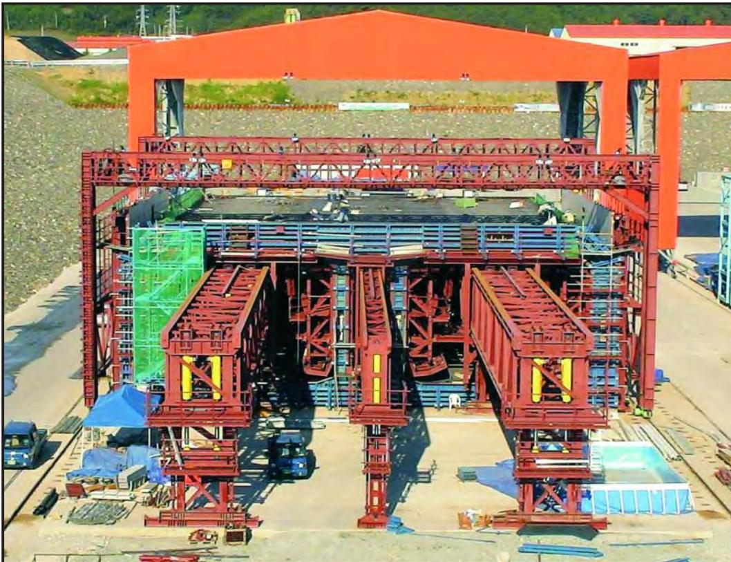
En los trabajos de construcción del túnel sumergido, en cuatro meses se prefabrican cuatro secciones del túnel de 180 m cada una con hormigón armado en un muelle seco, se cierran con mamparas de acero y se les colocan elementos de flotación.
