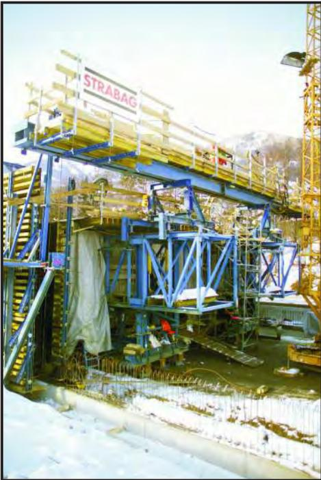
La distribución de las cargas del forjado durante el hormigonado se llevó a cabo con dos vigas de celosía usadas que estaban unidas a la cimbra SL-1. El mecanismo de desplazamiento consistía en ruedas con pestaña de diferente capacidad de carga.
