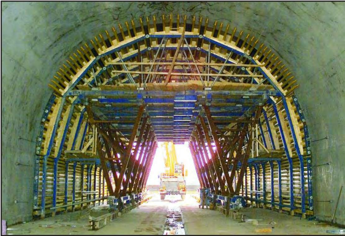
El carro de encofrado Doka estaba provisto de un paso de vehículos central de 4.20 m x 3.20 m para facilitar el tráfico de la obra en cada puesta.
