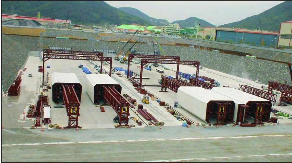
Después de fabricar las secciones del túnel, el muelle seco se llenará de agua. A los tubos, de unas 46.000 toneladas de peso, cerrados por los dos extremos se les colocan elementos de flotación y se pueden remolcar por barco hasta el lugar de inmersión.
