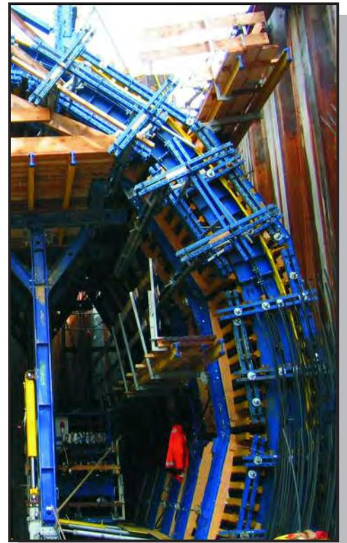
Tape de encofrado de acero dividido en secciones
