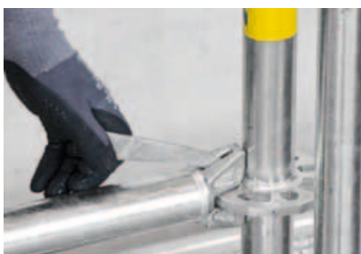
1. Riegel auf die Lochscheibe aufschieben
