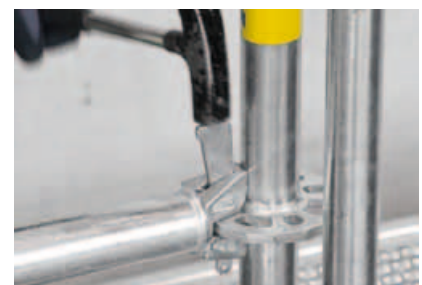
3. Mit dem Hammer festschlagen
