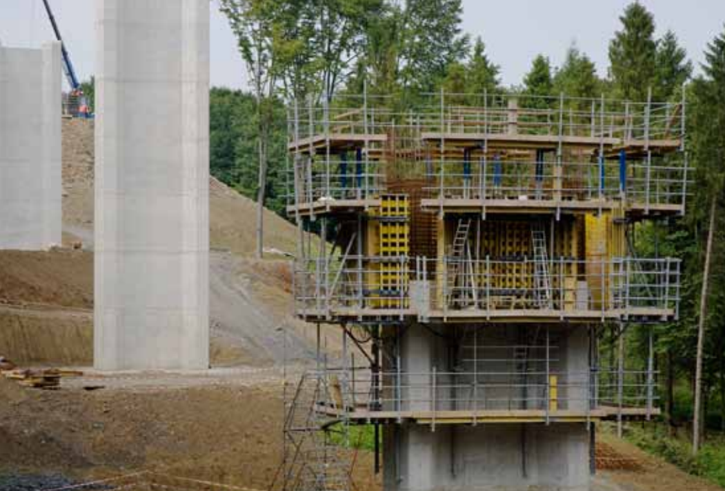
◀ Samošplhací bednění Doka SKE 50 plus v kombinaci s nosníkovým bedněním TOP 50
