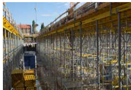
▲ Podepření předpínaných průvlaků podpěrnou konstrukcí Staxo 40 na výšku 7,35 m
