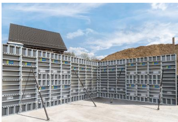
Opérations de coffrage ultraléger de murs s'étendant du sol au plafond, réalisées à la main avec le système DokaXlight avec des éléments de 1,50 m et de 3,00 m. Copyright : Doka
