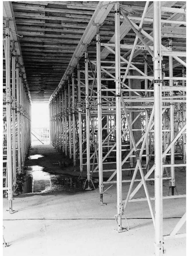
Rakennustyömaa: Bethanie-Krankenhaus, Chemnitz
