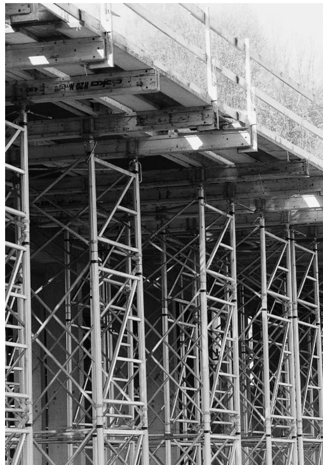
Rakennustyömaa: ARGE Ketschenburg, Stolberg
