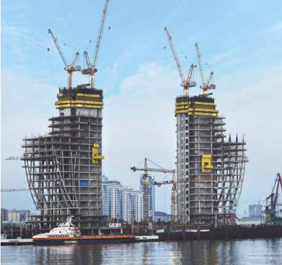
▲ Bakü'nün hava koşullarında vinçli bir sistemle ayda 3 kat çıkılması öngörülen projede, Doka otomatik tırmanır sistemleri ile kimi zaman ayda 5 katın tamamlanabilmesi sağlanmıştır.
