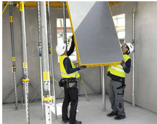
Montage sûr du coffrage modulaire de dalles DokaXdek depuis le sol
