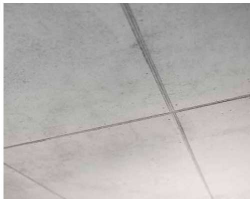
Parements béton esthétiques
