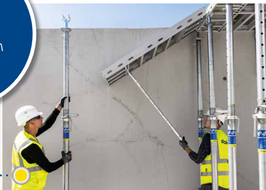
DokaXlight när man fäller upp
