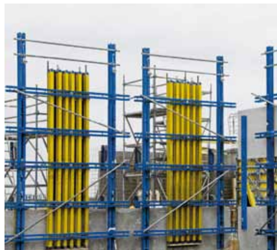
Schneller Baufortschritt, keine zusätzlichen Arbeits- und Schutzgerüste sowie hohe Wirtschaftlichkeit zeichnen die Fassadenschalung Top 50 aus.
