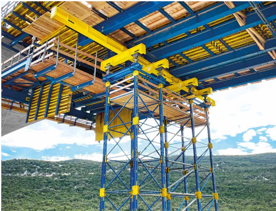
Dumanja Jaruga | Kroatien | Doka UniKit Lastturm 480kN, Joch- und Längsträger, Verlängerungen und Schwerlastjochs
