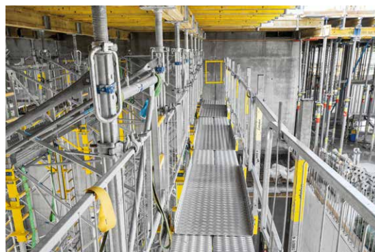
Platforma de montaj oferă o zonă de lucru extinsă la suprastructură, fără a compromite flexibilitatea sistemului sau performanța acestuia.
