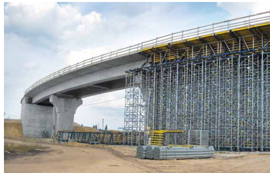
Ramele robuste ale Staxo 100 își demonstrează portantă înaltă chiar și atunci când nu sunt fixate la partea superioară.
