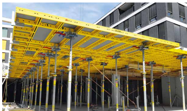
A DokaXdek asztalzsáluk használatban az ARGE Garnmarkt építkezésen (Götzis, Ausztria)
