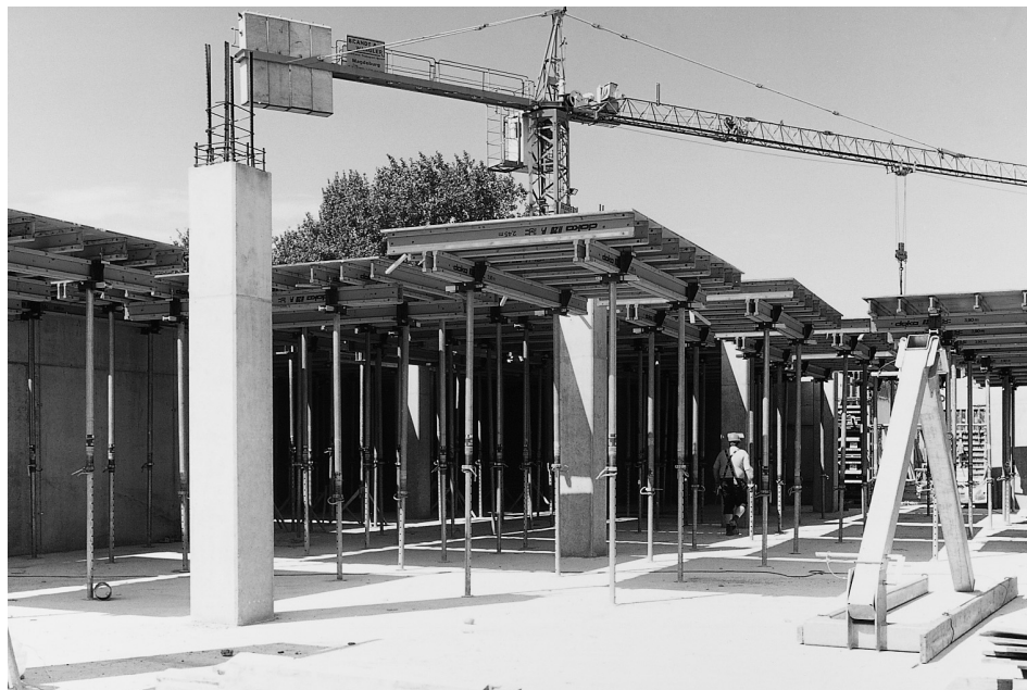
Obra: Hospital universitário, Magdeburg
