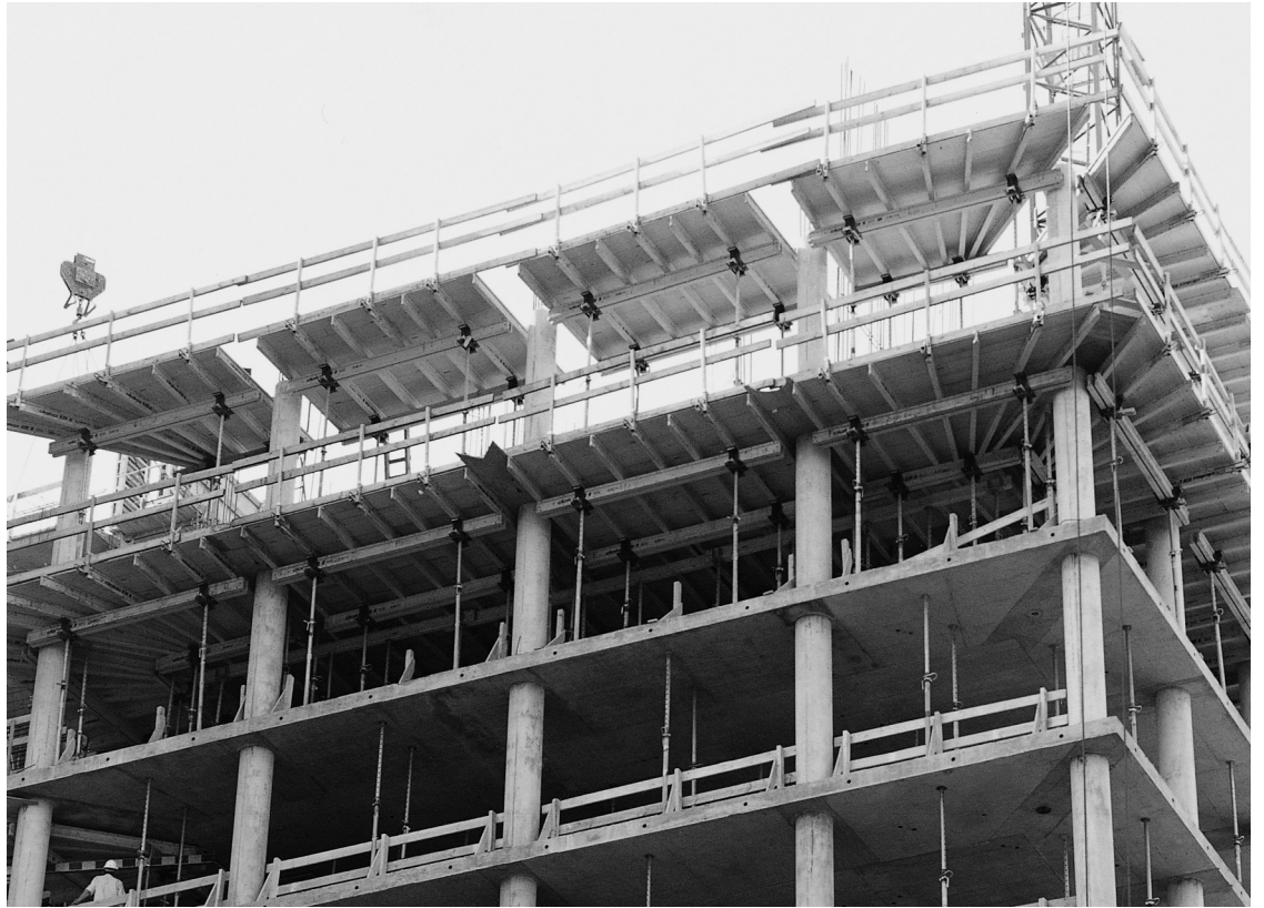
Obra: ARGE LVM Hochhaus Münster
