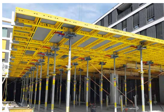
DokaXdek tafel bij ARGE Garnmarkt, Götzis, Oostenrijk
