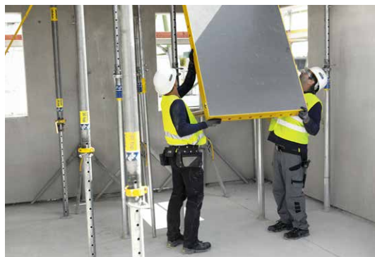
De DokaXdek paneel-vloerbekisting is een licht en flexibel systeem voor 2 bekisters.
