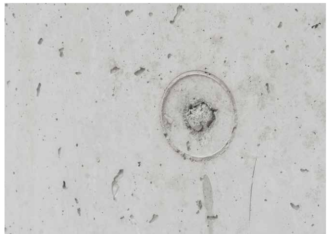
4. Vollständig verschlossenes Ankerloch
