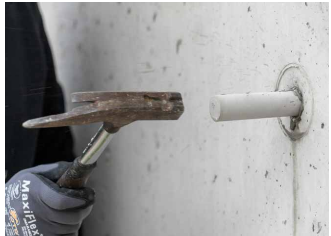
2. Betonkonus von der größeren Seite des Ankerlochs aus einschlagen
