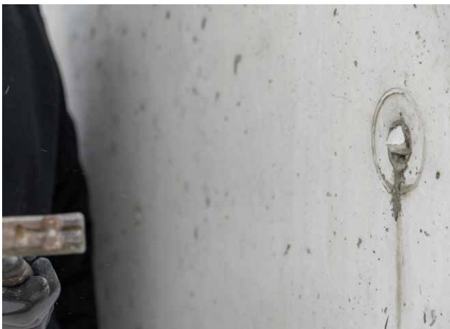
3. Überstehende Teile des Betonkonus mit Hammer abschlagen
