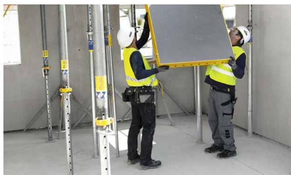
DokaXdek skydiniai perdangos klojiniai - lengva ir patogi dviejų darbuotojų sistema.
