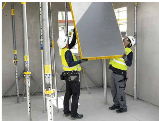
Sikker opsætning af DokaXdek kassette dækforskalling fra jorden
