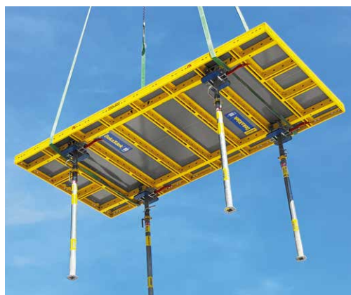
Utilizare rapidă datorită capetelor pivotante premontate
