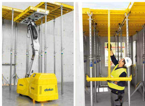
Travail ergonomique avec DokaXbot* et le cadre DokaXdek-I* (*versions démo).
