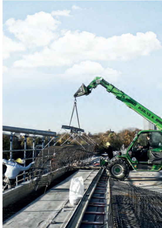
Vorgeflochtene Bewehrungskörbe können einfach von oben eingehoben werden.
