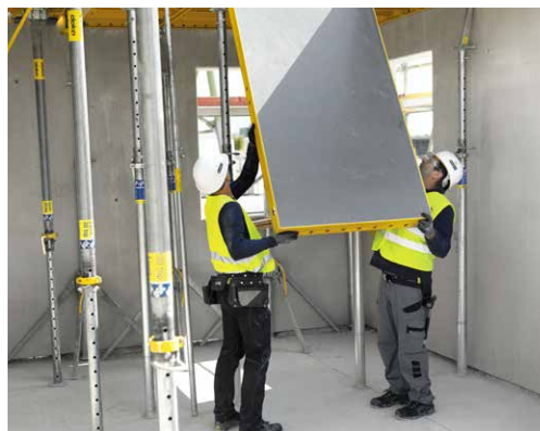
Montage sûr du coffrage modulaire de dalles DokaXdek depuis le sol
