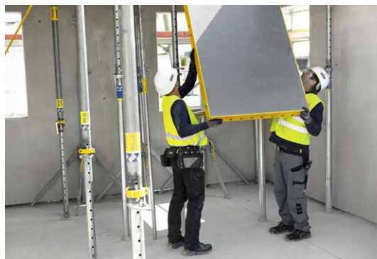
DokaXdek-kassetten er et lett og fleksibelt 2-manns kassettsystem.
