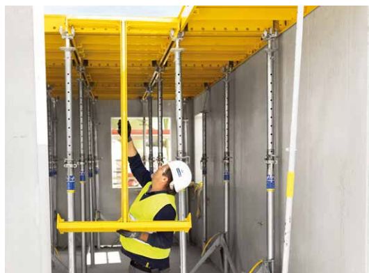
Ergonomisk arbeid med DokaXdek-I-ramme* (*Demoversjon)
