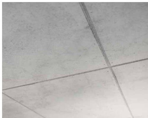
Rezultat frumos al betonului
