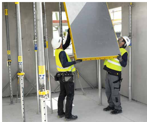
Montare sigură a panoului de cofraj DokaXdek, de la sol
