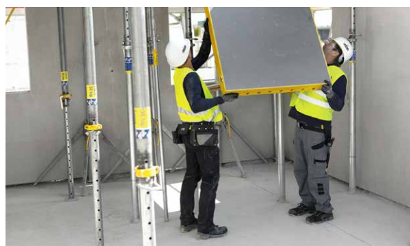
Montaggio in sicurezza da terra della cassaforma ad elementi per solai DokaXdek
