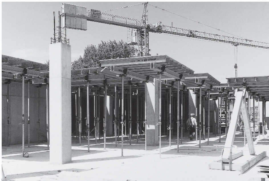
Gradbišče: UNI-klinika Magdeburg
