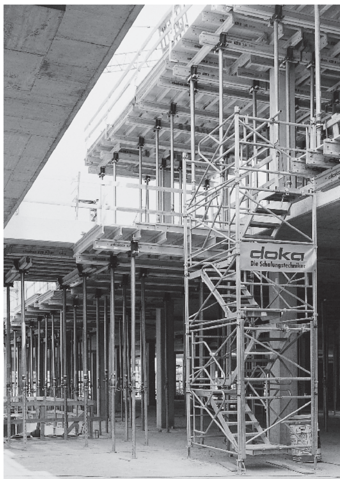
Gradbišče: ARGE Westmünster Center, Bocholt
