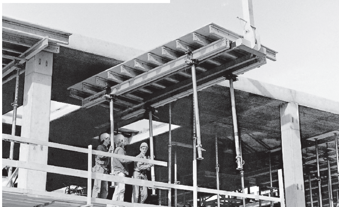
Gradbišče: Skladišče Klotzner, Linz
