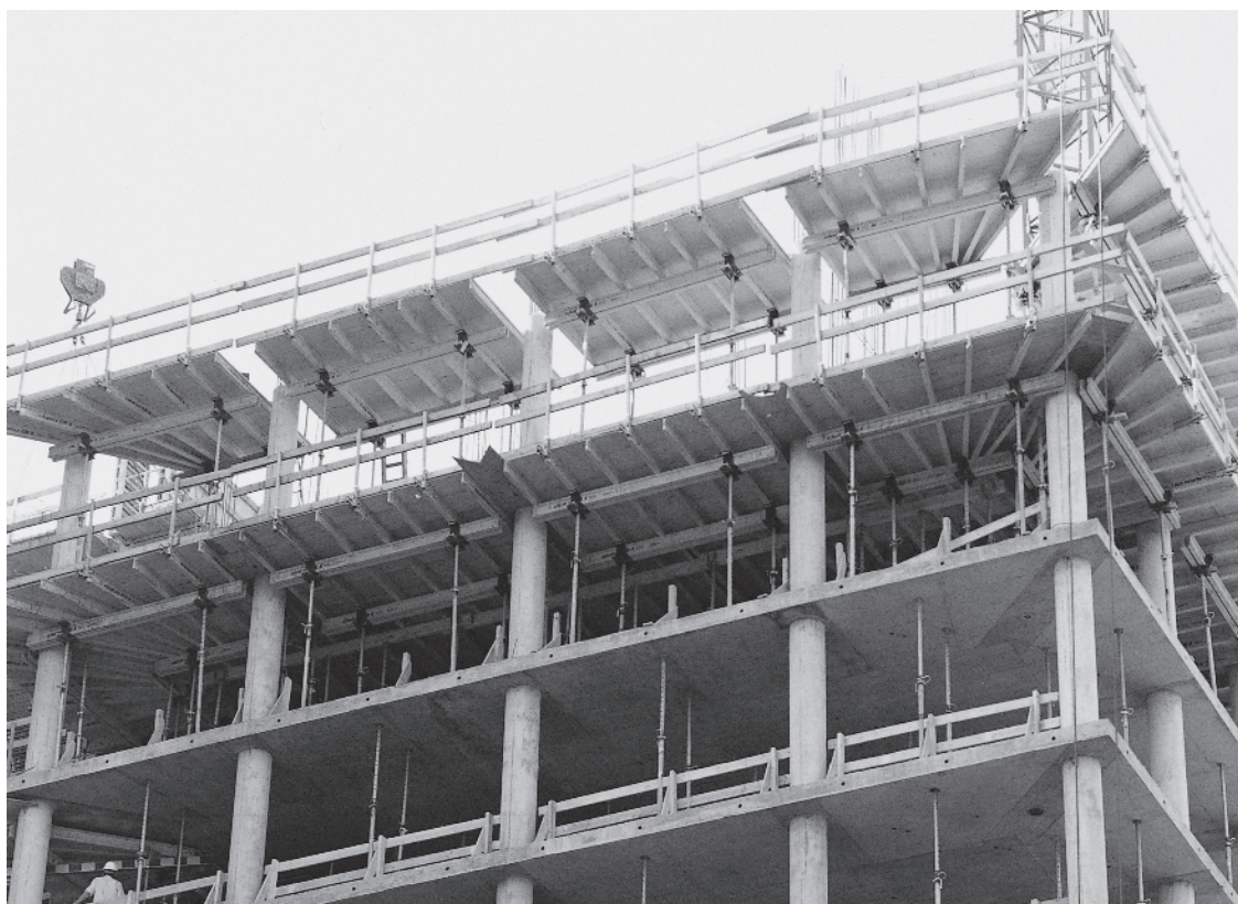
Gradbišče: ARGE LVM stolpnica v kraju Münster
