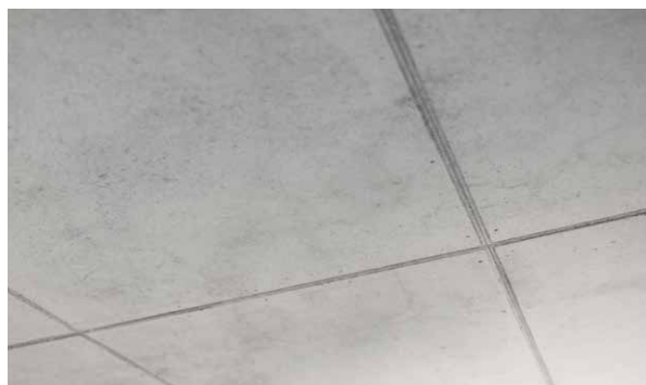
Отлично качество на бетона
