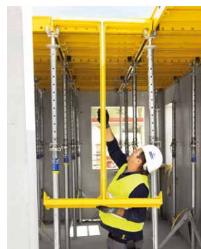
Ергономична работа с DokaXbot Lift и DokaXdek-I рамка* (*демонстрационна версия).
