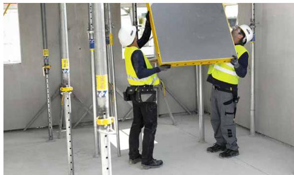
DokaXdek панел-кофражът за плоча е лека и гъвкава система от елементи, която се обслужва от двама работници
