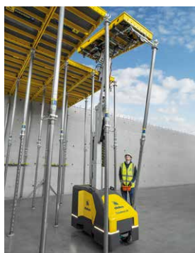
Lavorare in modo ergonomico con DokaXbot Lift e i tavoli DokaXdek-I* (*versione demo).
