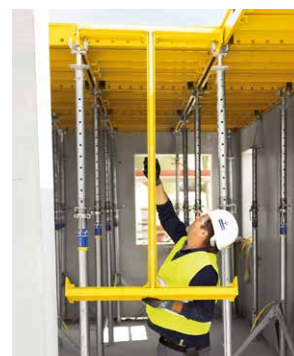
Lavorare in modo ergonomico con DokaXbot Lift e i tavoli DokaXdek-I* (*versione demo).
