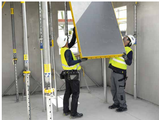
Bezpečná montáž DokaXdek panelového stropného debnenia zo zeme
