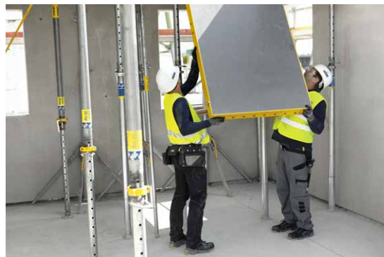
DokaXdek panelna stropna oplata lagan je i fleksibilan sustav elemenata za 2 osobe.
