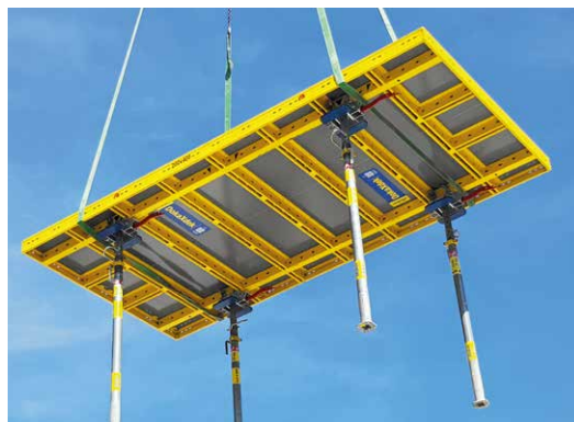
Brza uporaba zahvaljujući predmontiranim zakretnim glavama
