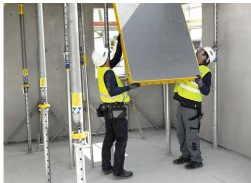
Panelowe deskowanie stropowe DokaXdek to lekki i elastyczny 2-osobowy system panelowy.
