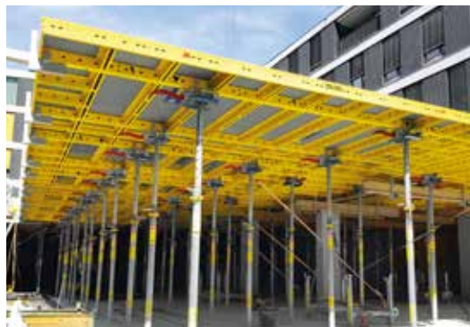
Bednicí stůl DokaXdek na stavbě ARGE Garnmarkt, Götzis – Rakousko
