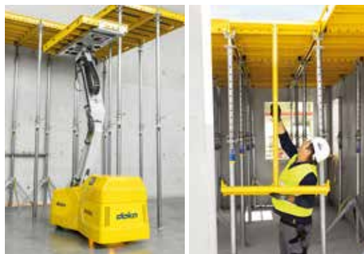
Ergonomická práce s DokaXbot* a rámem DokaXdek-I* (*prototyp).
