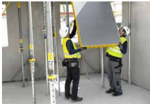
Panelové stropní bednění DokaXdek představuje lehký a flexibilní systém, k jehož obsluze stačí 2 osoby.
