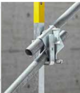
Margu aizsargsistēma XP – viens statņu veids visiem malu aizsardzības veidiem (koka, režģu un cauruļu margām)
