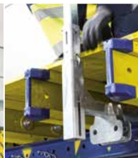
Margu aizsargsistēma XP – viens statņu veids visiem malu aizsardzības veidiem (koka, režģu un cauruļu margām)
