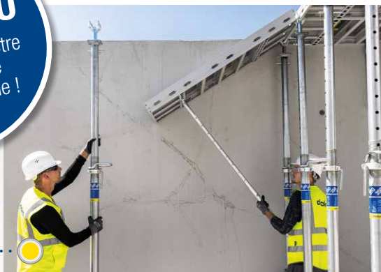
DokaXlight lors du pivotement vers le haut
