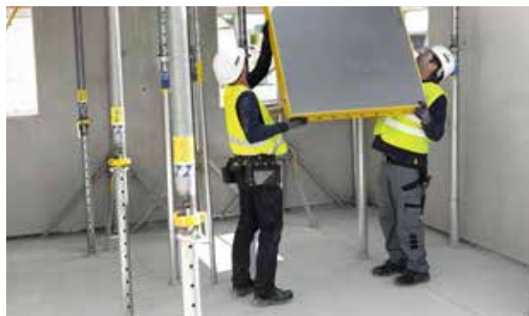
DokaXdek-panelni opaž plošče so lahek in prilagodljiv sistem elementov za dve osebi.
