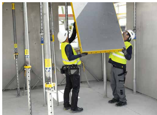
Le coffrage modulaire de dalles DokaXdek est un système de panneau flexible et léger pour une équipe de deux coffreurs.
