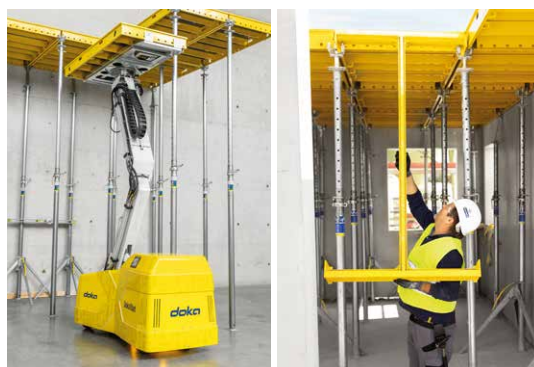
Ergonomisk arbejde med DokaXbot* og DokaXdek I-ramme* (*demoversioner).
