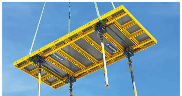
Greitas montavimas dėl iš anksto sumontuotų pasukamų galvų.
