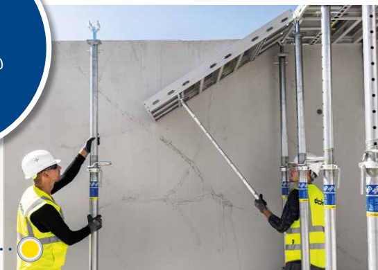
DokaXlight a ser levantado
