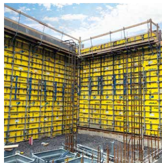
Progetti con carichi di ancoraggio critici
