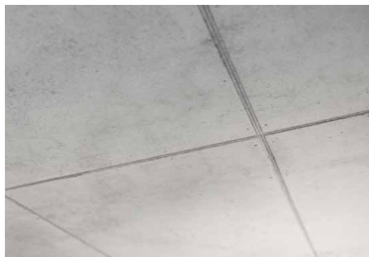
Dobri rezultati betoniranja
